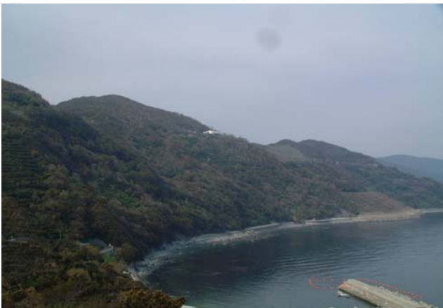
写真-1 名取トンネル周辺の全景
